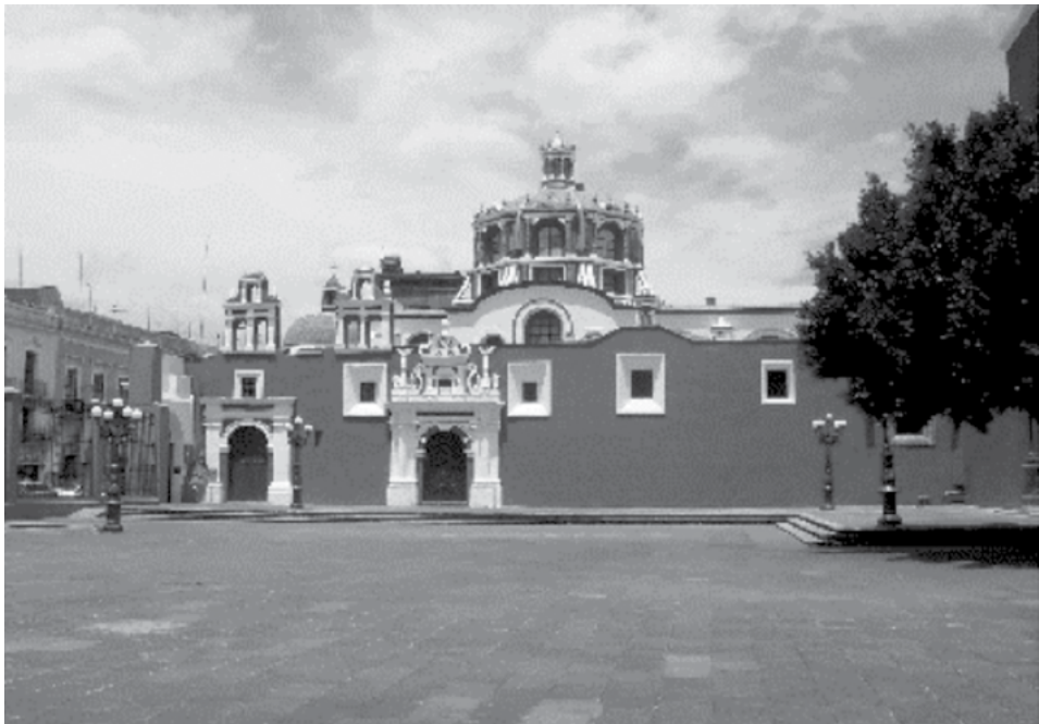
IMAGEN 25. Exterior de la capilla del Rosario, Santo Domingo, Puebla
