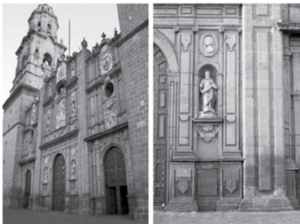
IMAGEN 8. Fachada central y portada lateral
